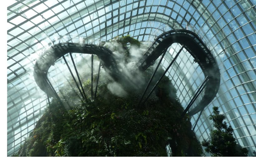
Nebulizadores en marcha dentro del Jardín Botánico Gardens by the Bay, Malasia. Una correcta combinación de nebulización y ventilación no sólo puede hacer descender la temperatura en 11°C durante el verano sino que además ayuda a mantener una deseable humedad relativa mediante la evaporación del agua residual (foto © José Manuel Santos)
